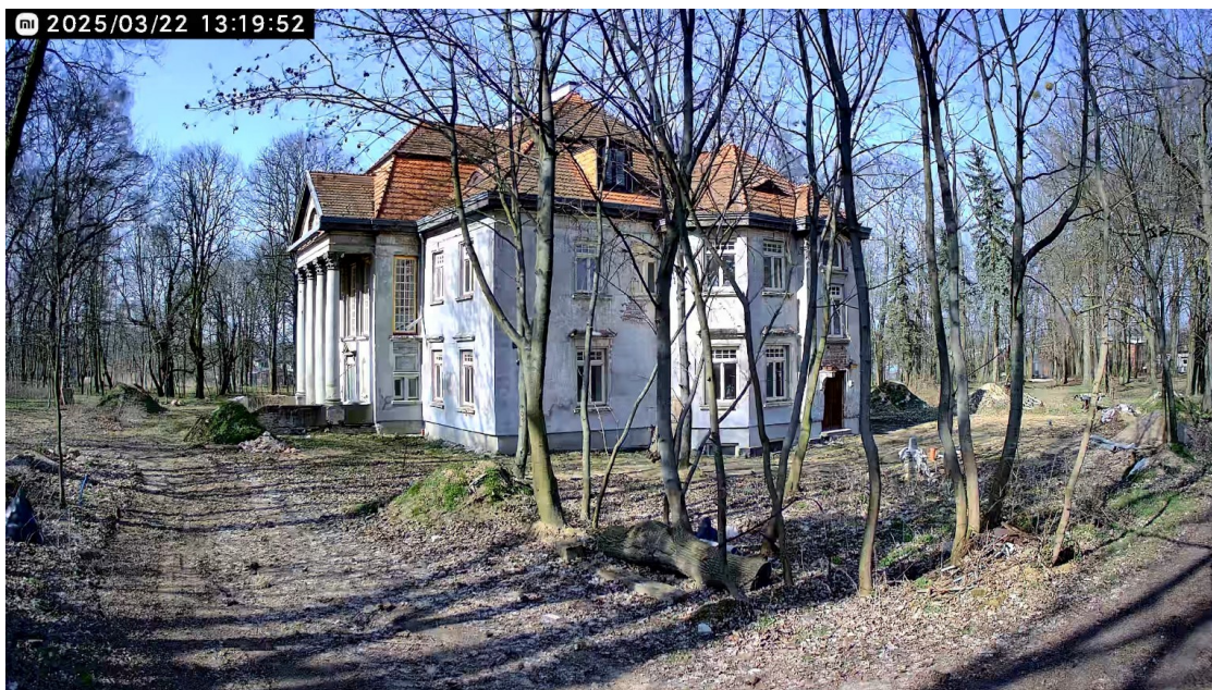
Pałac i jego parkowe otoczenie w trakcie współczesnych prac porządkowych i restauratorskich.
