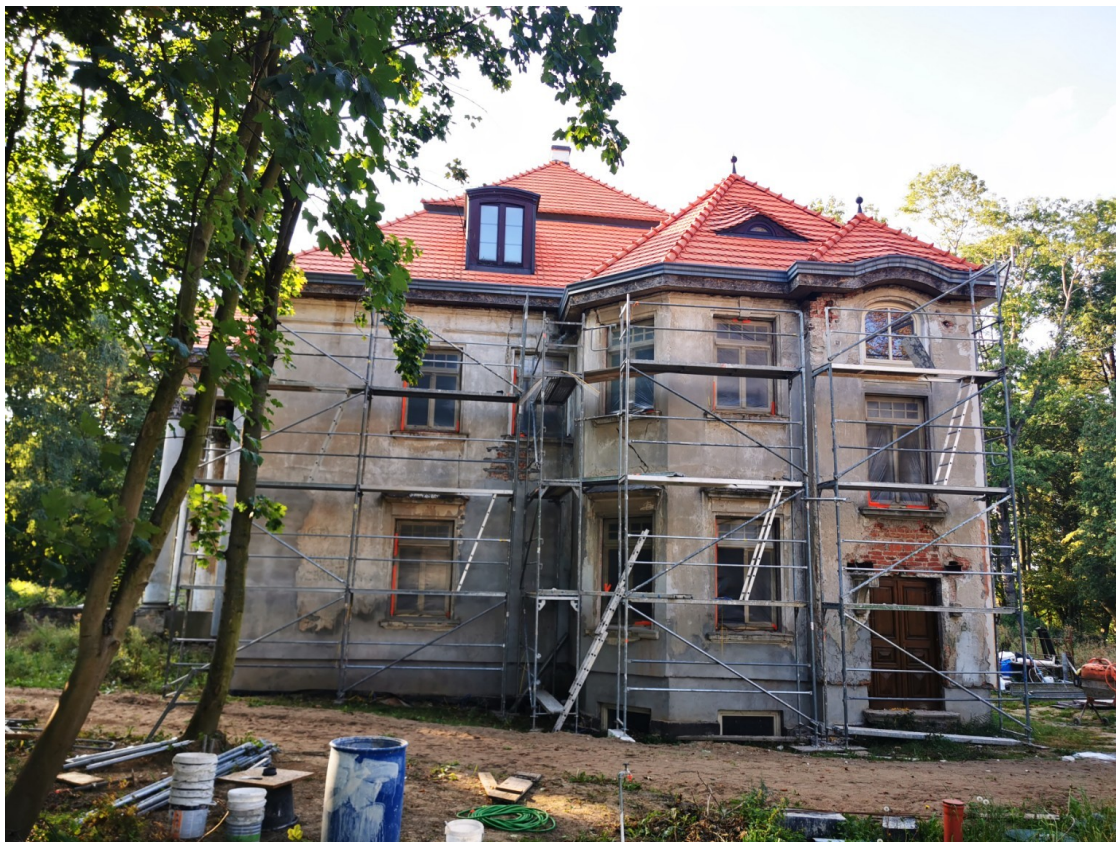
Prace przy elewacji pałacu - współczesny etap restauracji zabytku.
