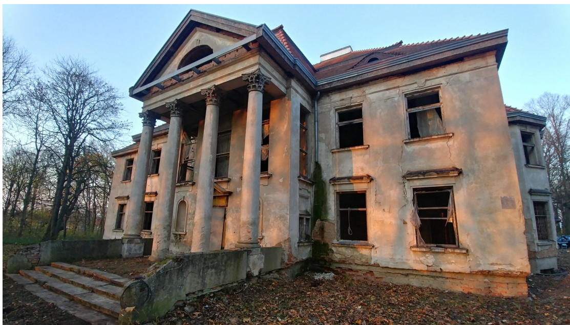
Pałac w okresie wymagającym szerokich prac ratunkowych i konserwatorskich.
