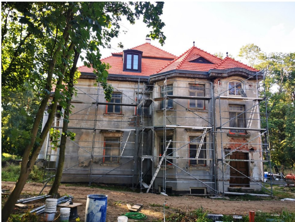
Prace przy elewacji ogrodowej/bocznej - dokumentacja współczesnego remontu.
