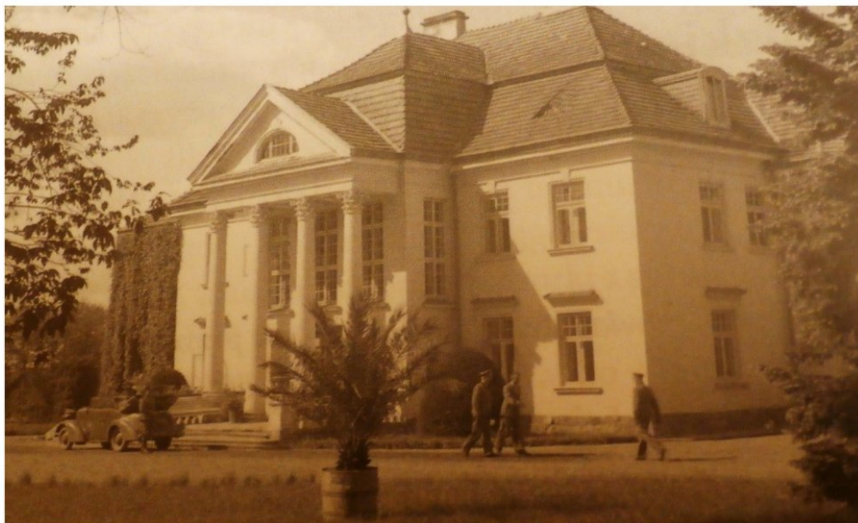
Fotografia wojenna - bezcenny punkt odniesienia dla rekonstrukcji wyglądu elewacji i otoczenia.
