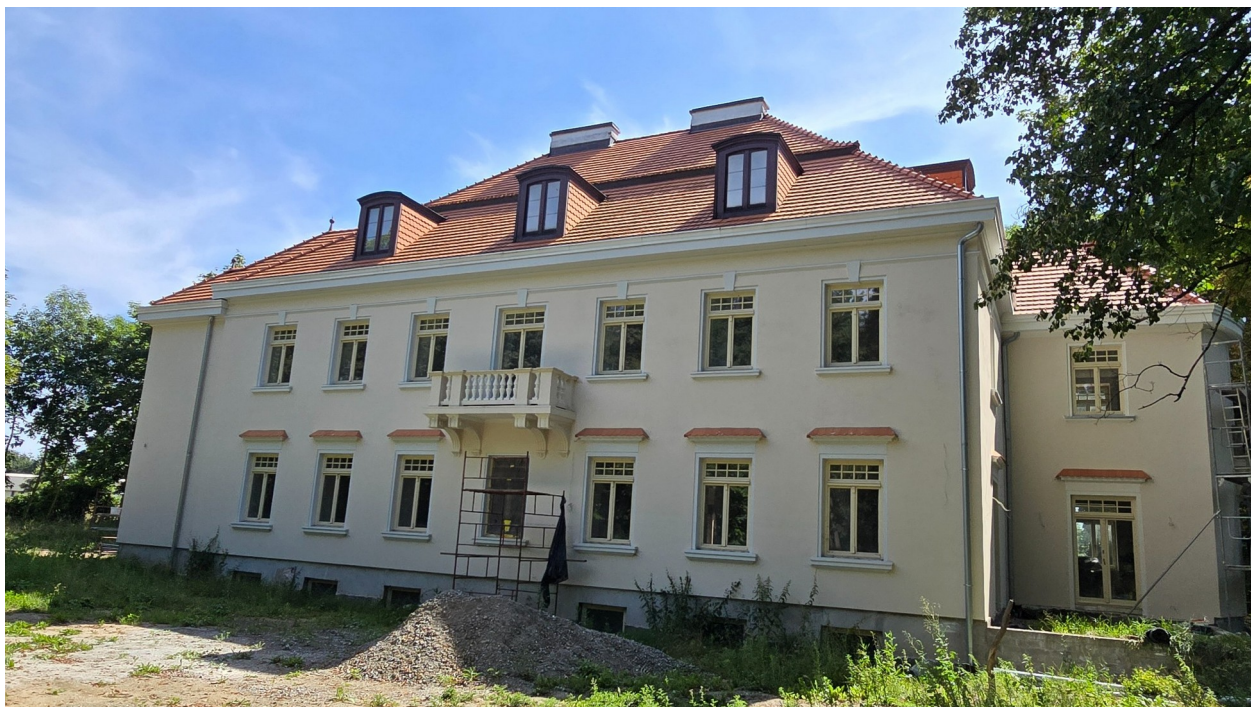
Elewacja po wykonaniu znacznej części prac - dokumentacja stanu rzeczywistego.
