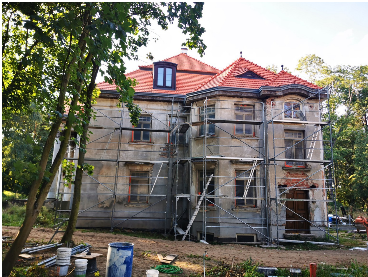
Prace przy elewacji ogrodowej/bocznej - dokumentacja współczesnego remontu.
